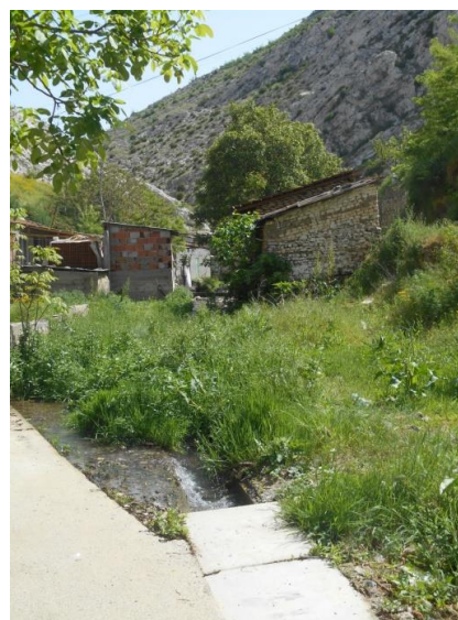
Сл.8 Почетен дел на каналот
