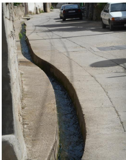
Сл.7 Постоечки канал
