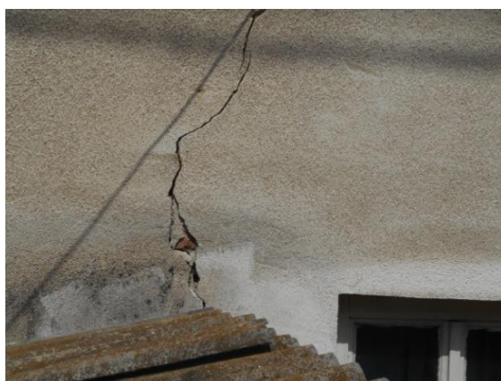
Сл.2 Дополнителни пукнатини во куќите
